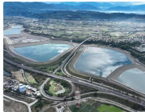
石門水庫阿姆坪防淤隧道
